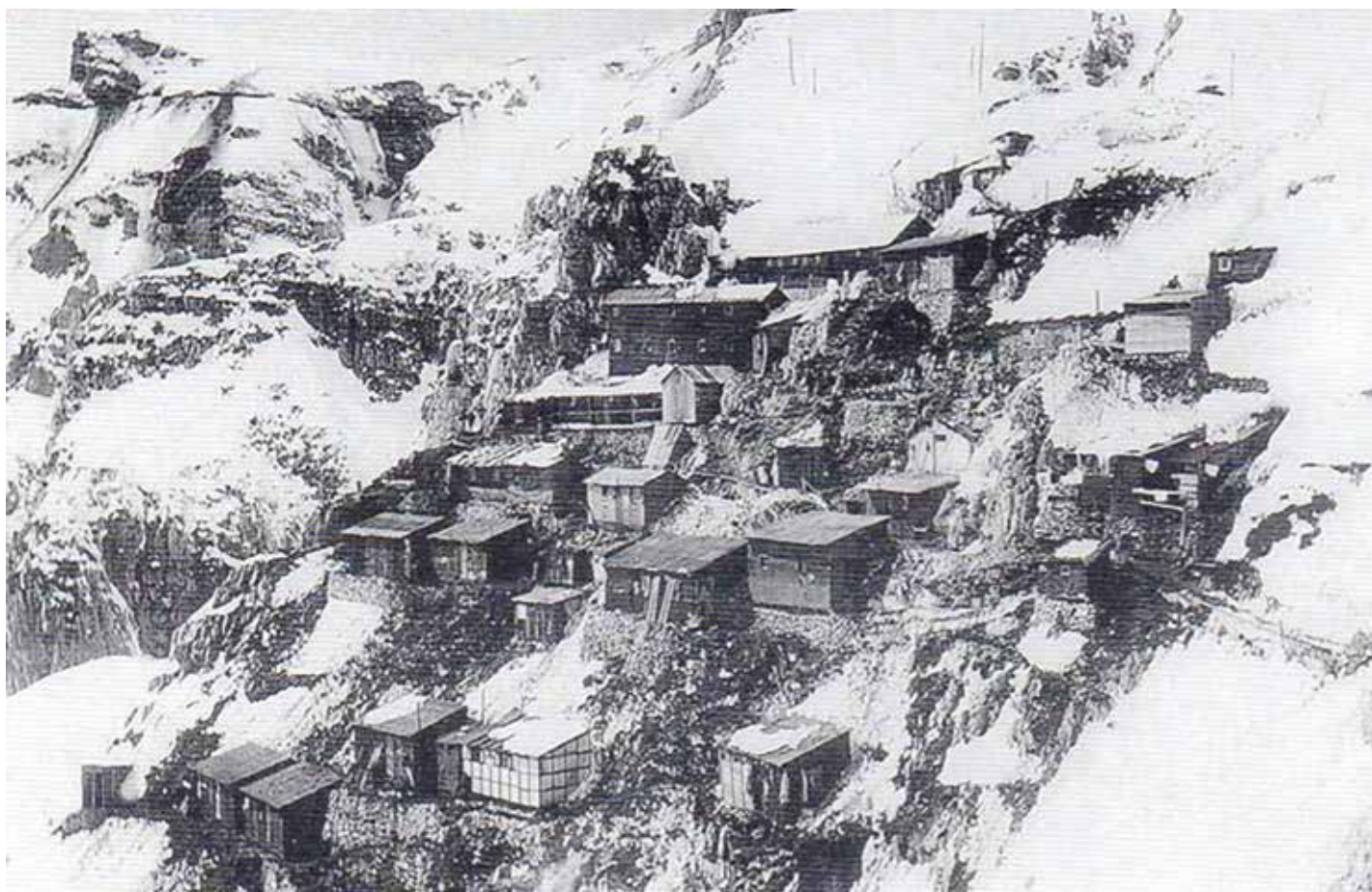
Baraccamenti italiani a ridosso delle Porte del Pasubio.
